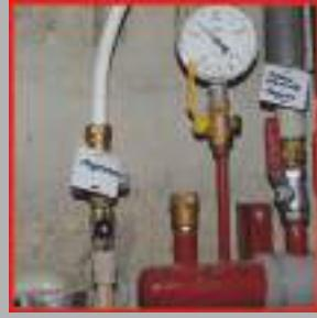
До начала розжига котла открыть линию подпитки системы отопления и контрольную линию заполнения расширительного бака. Убедиться, что давление по манометру, установленному на котле, не растет.
